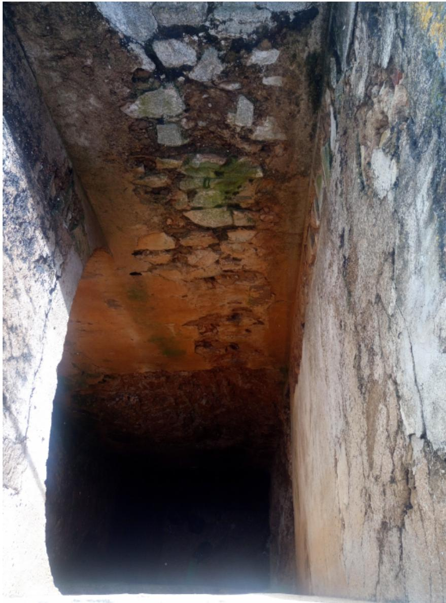
No se ha detectado la presencia de nivel freático, el pozo con una profundidad de 12 metros se encuentra seco a 20/04/2018
